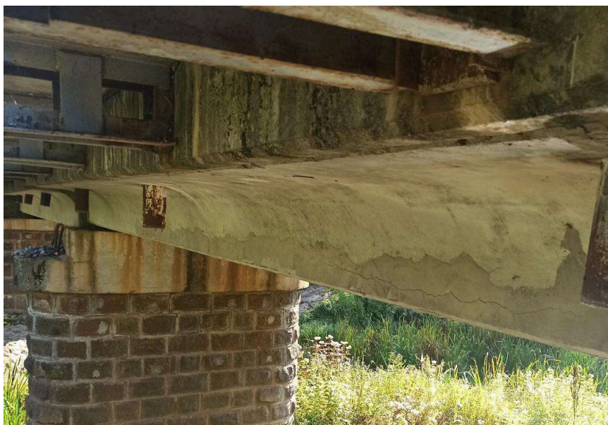
8 pav. Perdangos plokščių trūkiai, išplauti kalčio karbonatai.
